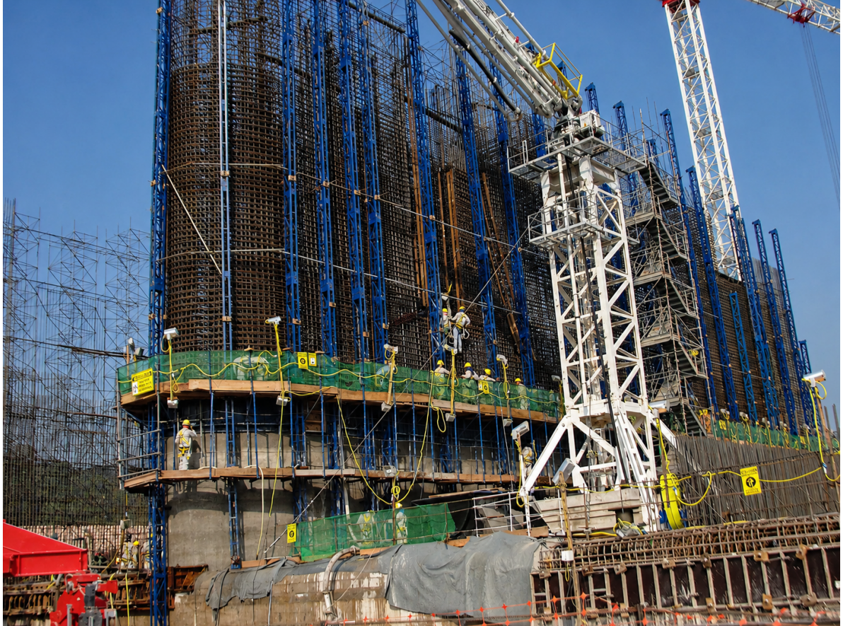
Fig. 23 Concretagem do pilar do vertedouro (UHE São Manoel)
